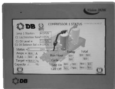
Visión 2020i, un avanzado controlador electrónico programable diseñado específicamente para las aplicaciones y control preciso de las enfriadoras de compresor de tornillo de velocidad variable Dunham-Bush, WCFX-V.
